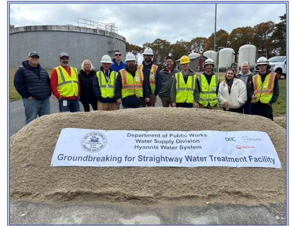
Personal de Hyannis Water System en la innovadora ceremonia para la nueva Instalación de Tratamiento de Agua Potable de Straightway
