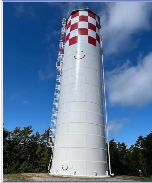
Rehabilitación completada del Tanque de Almacenamiento de agua Mary Dunn I
